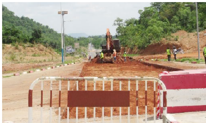
Image d'un chantier d'EBOMAF visité par le ministre
