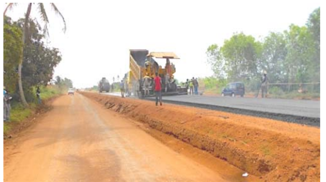
L'axe Avépozo-Aného en réhabilitation
