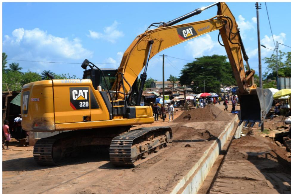
Remblai technique effectué par une pelle mécanique sur la rue du marché de Kpalimé
