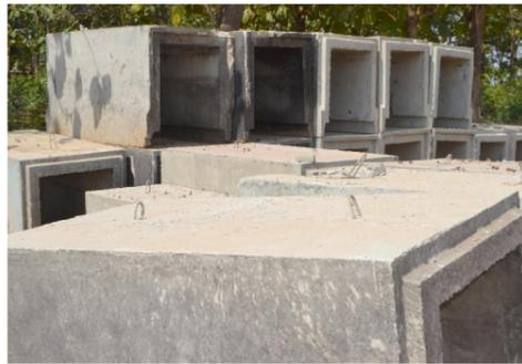
Des préfabriqués de caniveaux rejetés pour non conformité aux normes par la mission de contrôle
