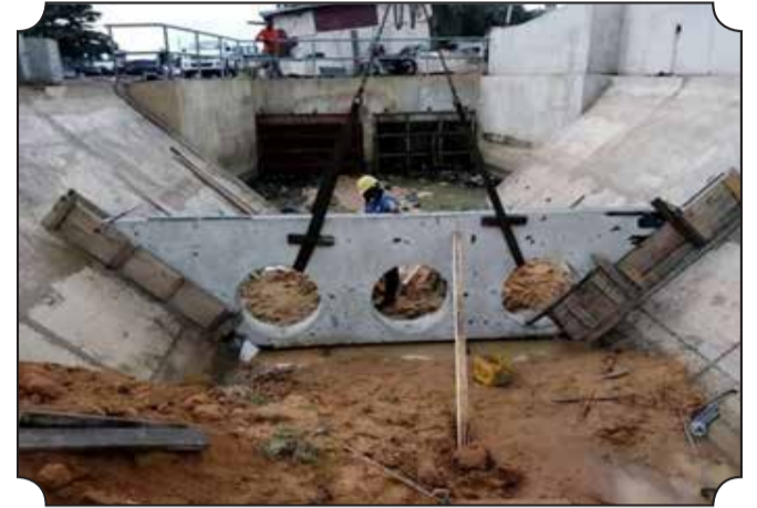
● Vue partielle des travaux/IMG MIAWODO
