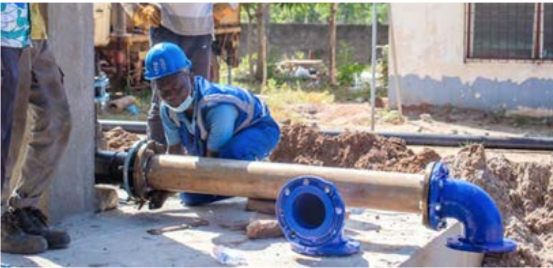
Une adduction d'eau en cours d'installation dans la région
