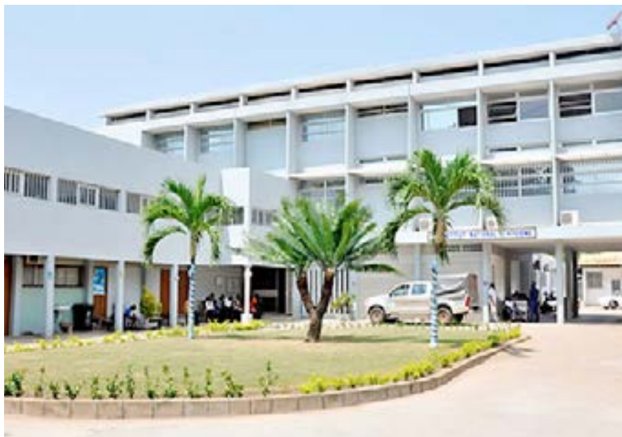
Aperçu du CHU Campus
