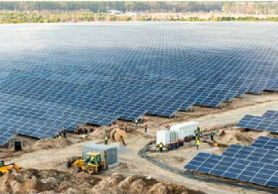
Des plaques solaires
