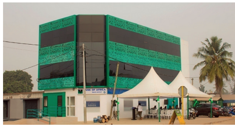
L'immeuble qui abrite l'agence BOA-TOGO- Wuiti
