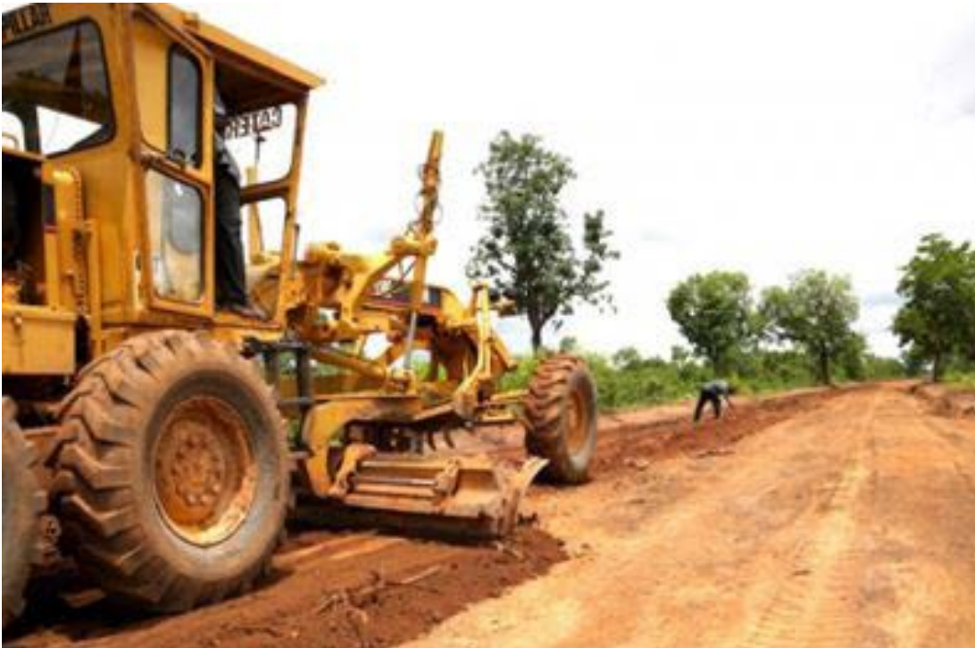
Construction d'une piste rurale
