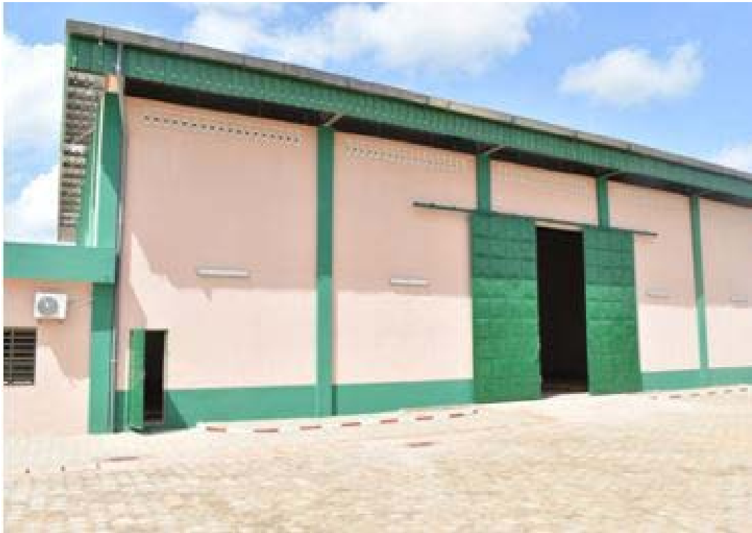
Un magasin de stockage
