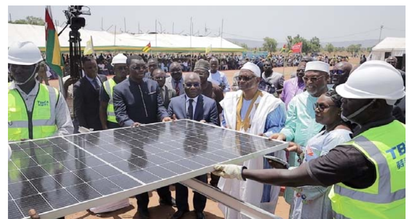
Pose du panneau solaire par les autorités
