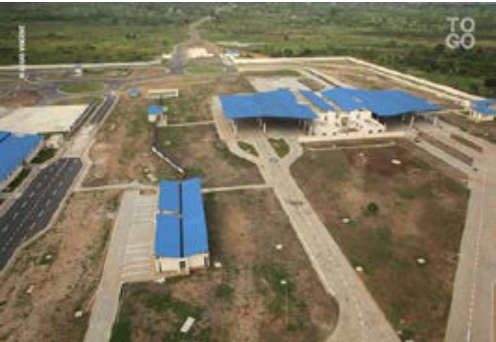
Le poste frontière juxtaposé de Noépé entre le Togo et le Ghana
