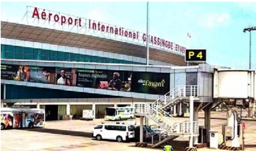
Vue partielle de l'infrastructure aéroportuaire Gnassingbé-Eyadema
