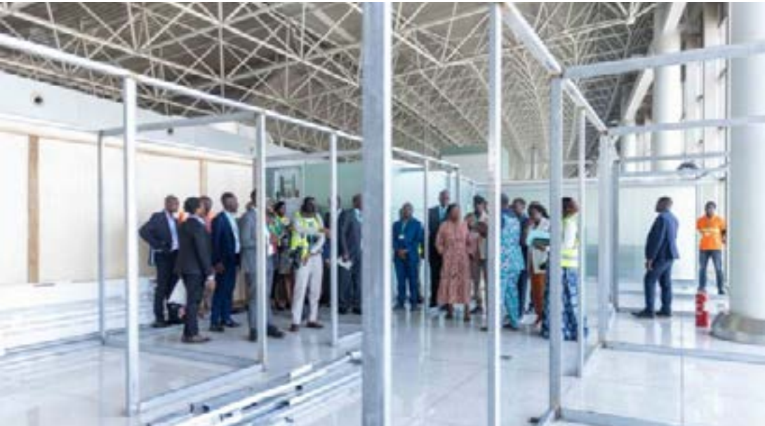
Des autorités constatent l'avancée des travaux sur le site de l'aéroport de Lomé
