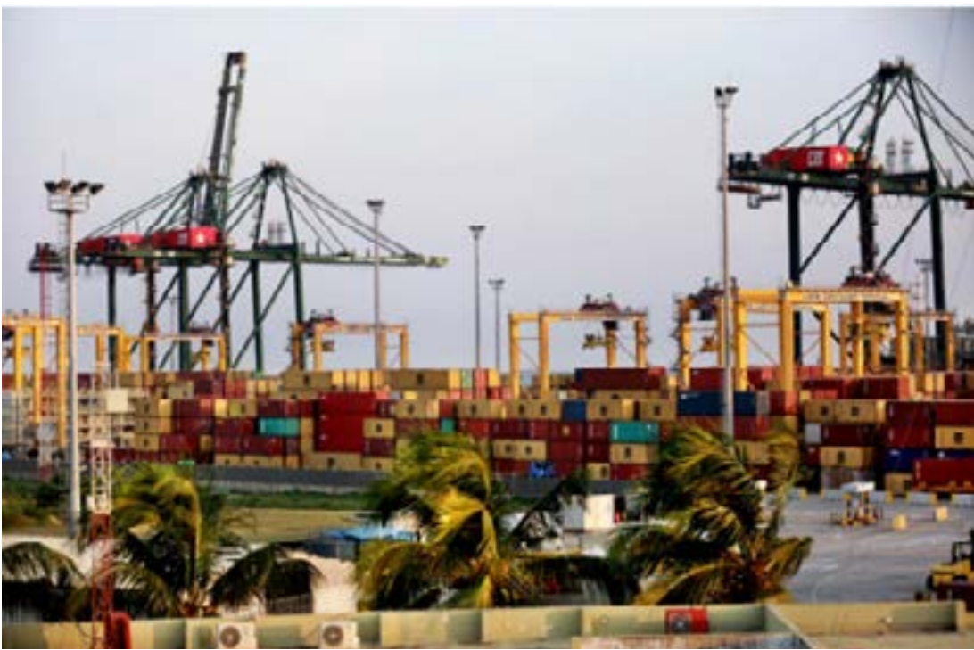
Entreposage des conteneurs au Port autonome de Lomé
