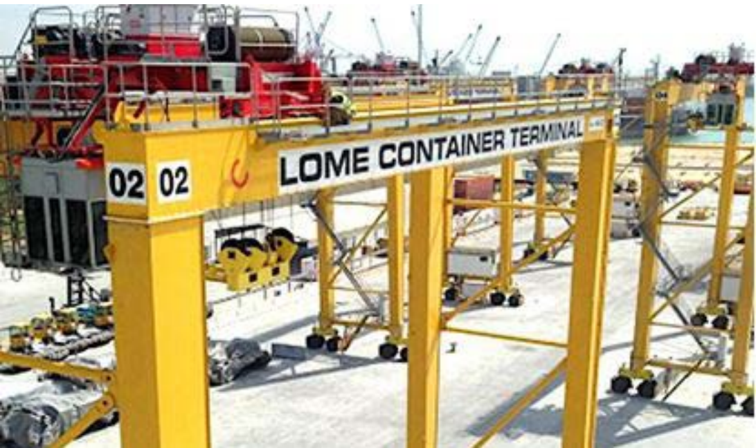
Infrastructure moderne au port de Lomé
