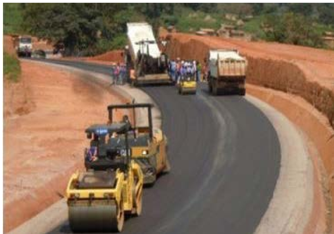
Des travaux de revêtement sur la route nationale numéro 1
