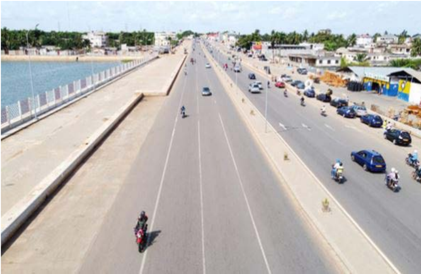
Vue large sur le du dédoublement sur la RN5
