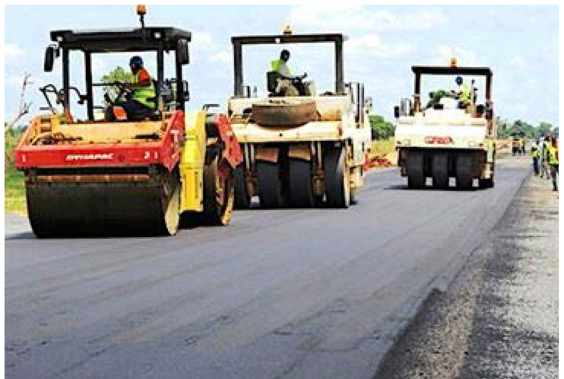
Travaux de revêtement de voies
