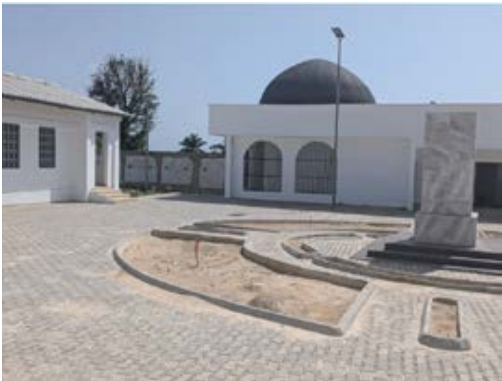
Mausolée Kléber Dadjo en construction à Siou
