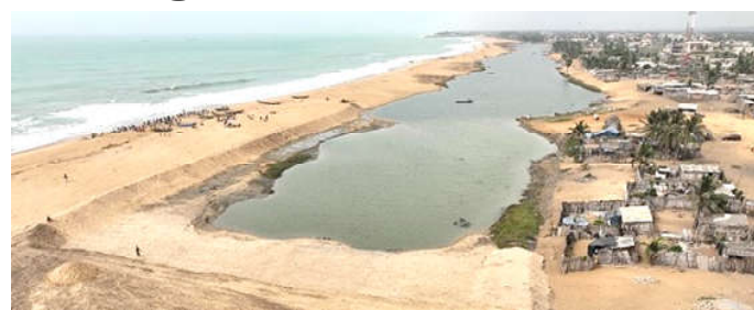
Vue de l'état initial du site de comblement d'un des bras morts lagunaire d'Aného (crédit : Boskalis)
