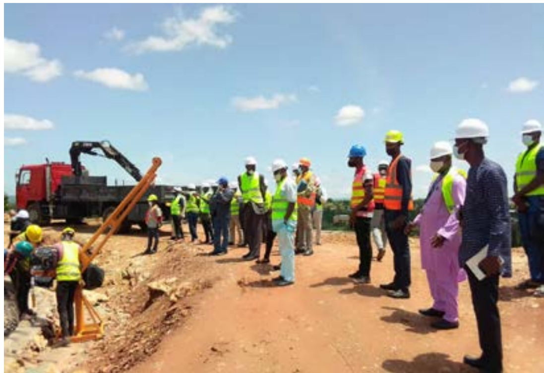
Etat d'avancement des travaux du projet Eau et Assainissement à Sokodé (Image d'archives)
