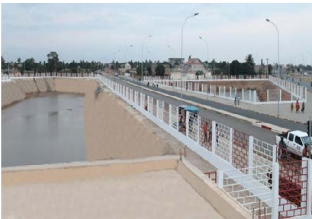
Bassin de rétention d'eau de Agoè deux lions
