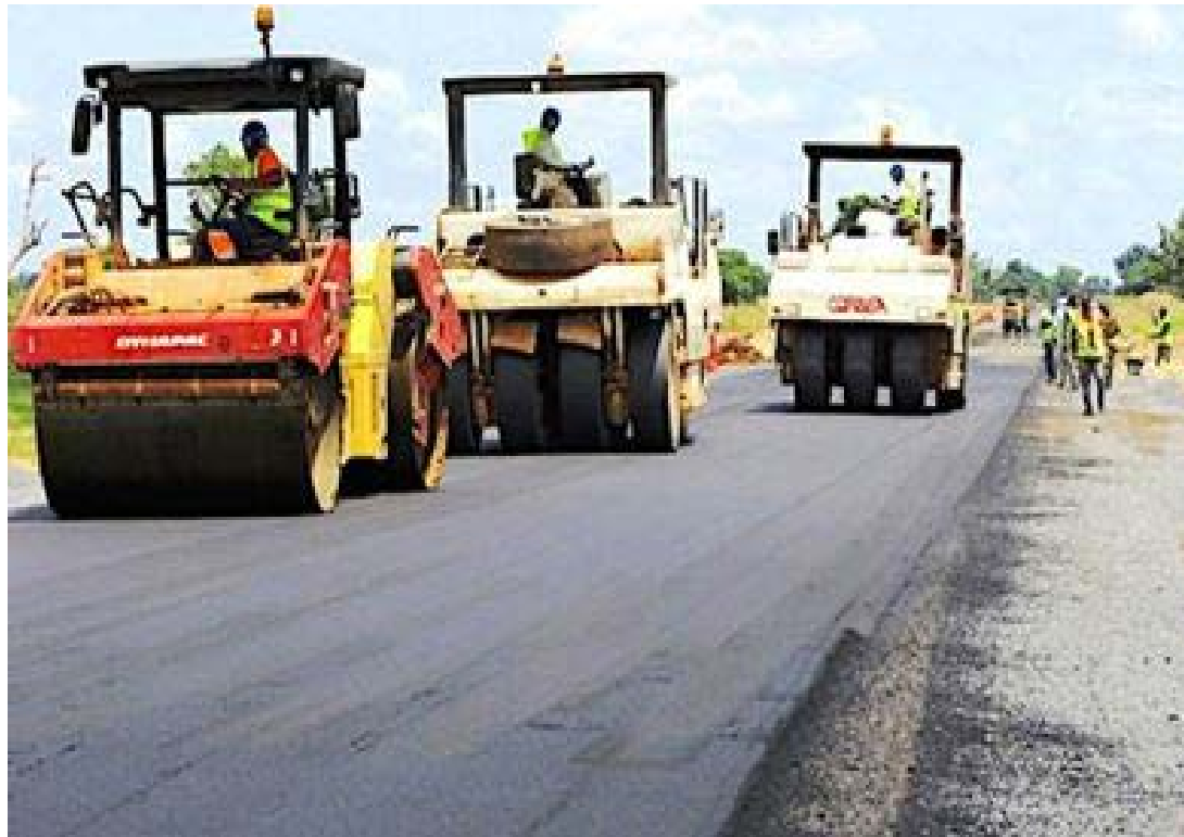
Travaux de revêtement de voies
