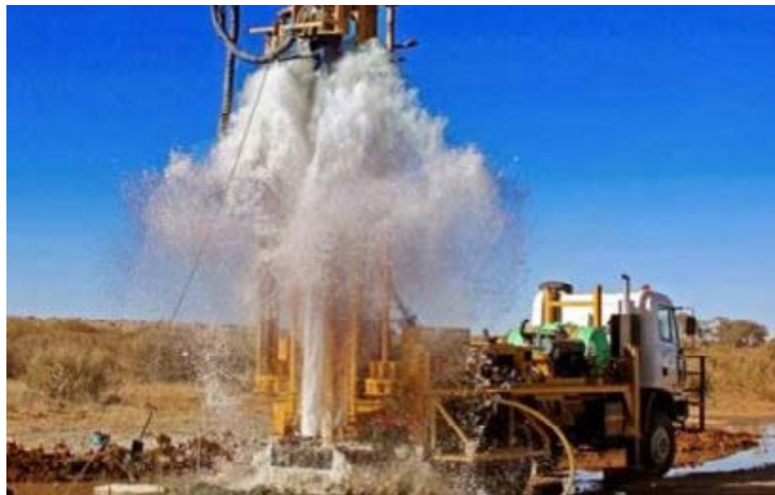
Travaux de réalisation de forage au nord Togo
