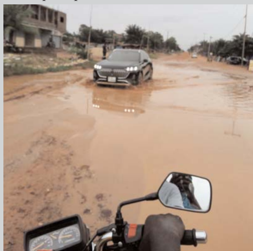
Une vue du tronçon Wellcity après la pluie de lundi dernier
