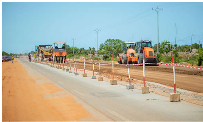
Les travaux sur la route Avépozo-Aného lors de la réhabilitation (archives)
