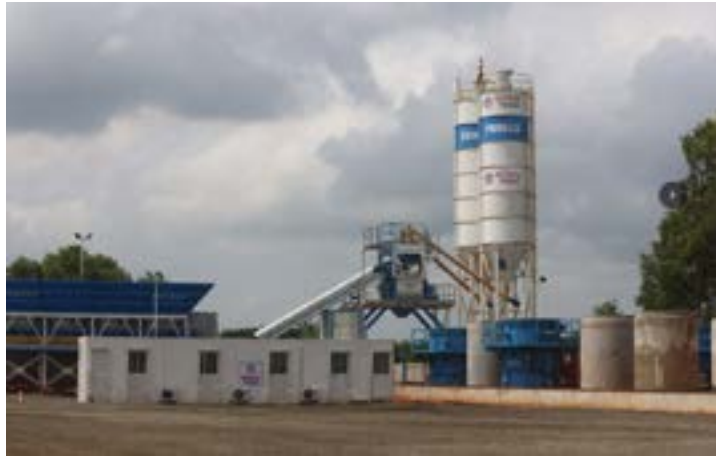
Usine spécialisée dans la préfabrication des tuyaux bas carbone
