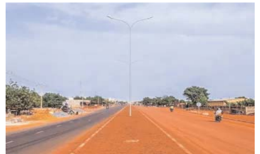
Une route en aménagement
