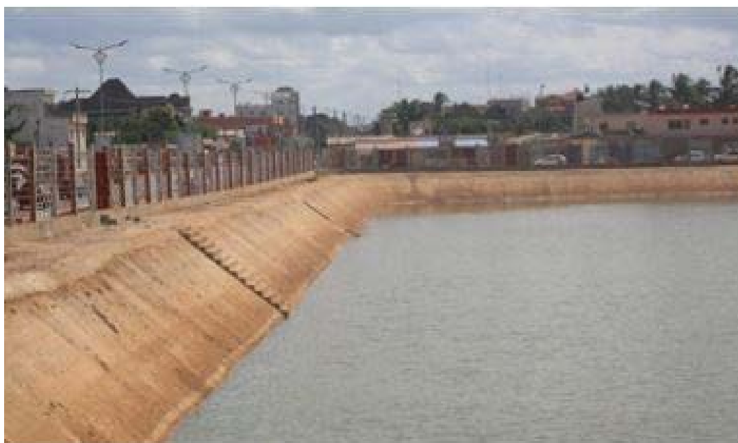
Un bassin de rétention d'eau de pluie à Lomé
