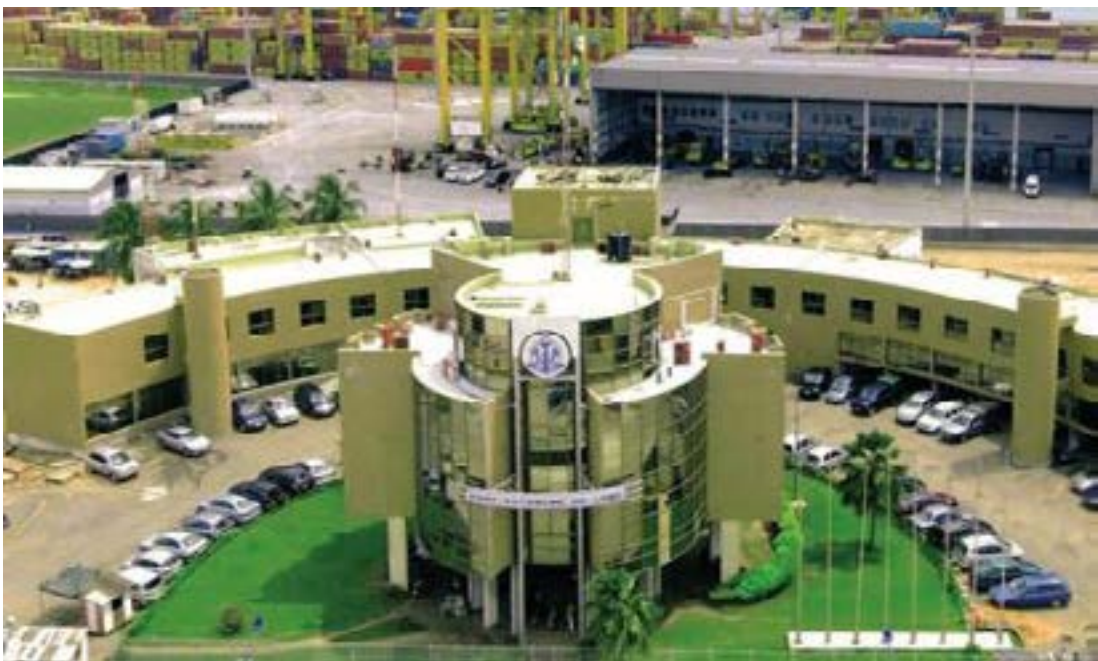
Vue partielle de l'infrastructure portuaire de Lomé (Image prise sur internet)
