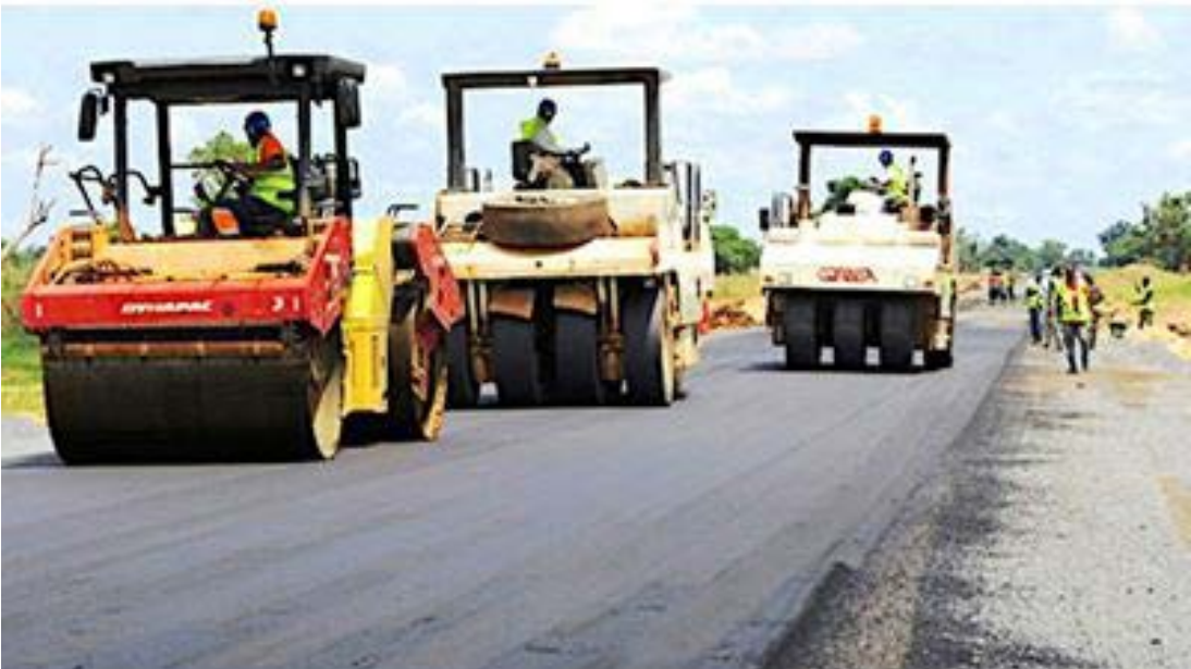
Travaux de revêtement de voies
