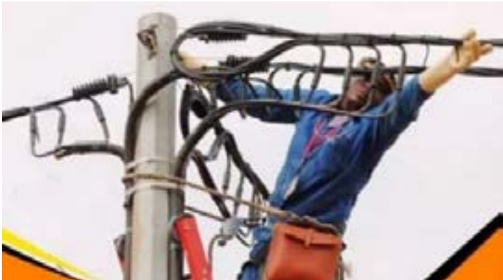
Travaux de maintenance d’un réseau électrique
