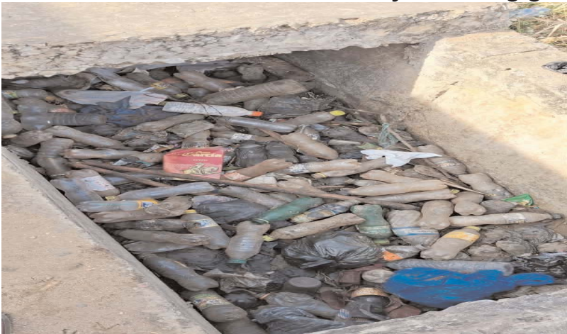
Un caniveau bouché par des ordures
