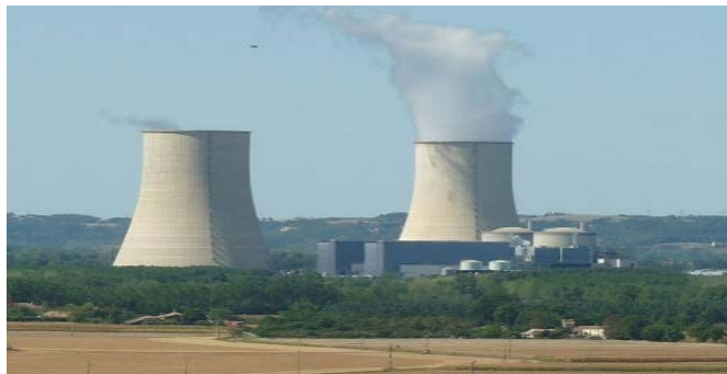
• La centrale nucléaire de Golfech est située au bord de la Garonne. Jack ma / WikimediaCommons
