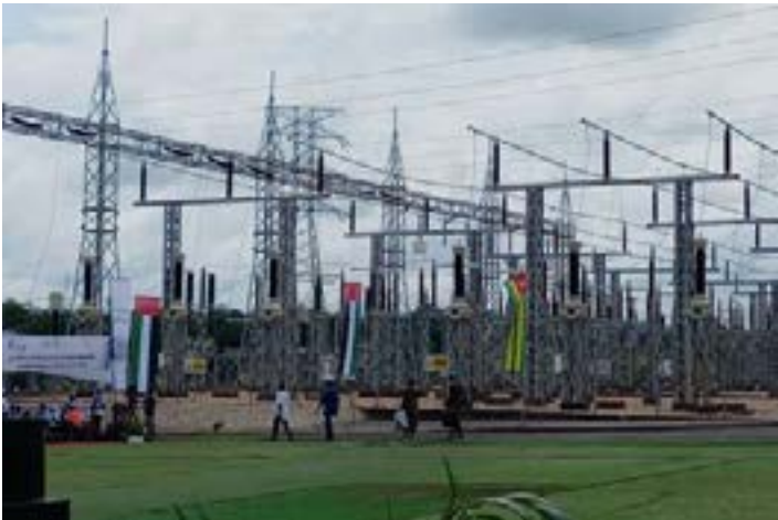
Centrale photovoltaïque de Blitta
