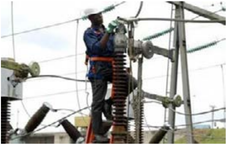
Un technicien sur des installations électriques
