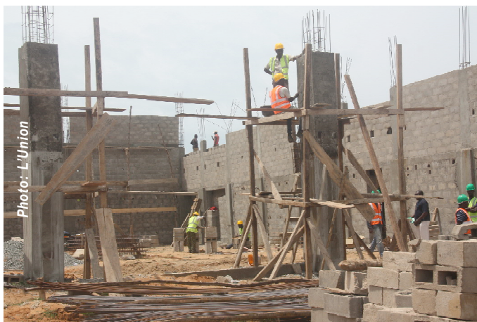
Le nouveau magasin décor pour la douane en construction
