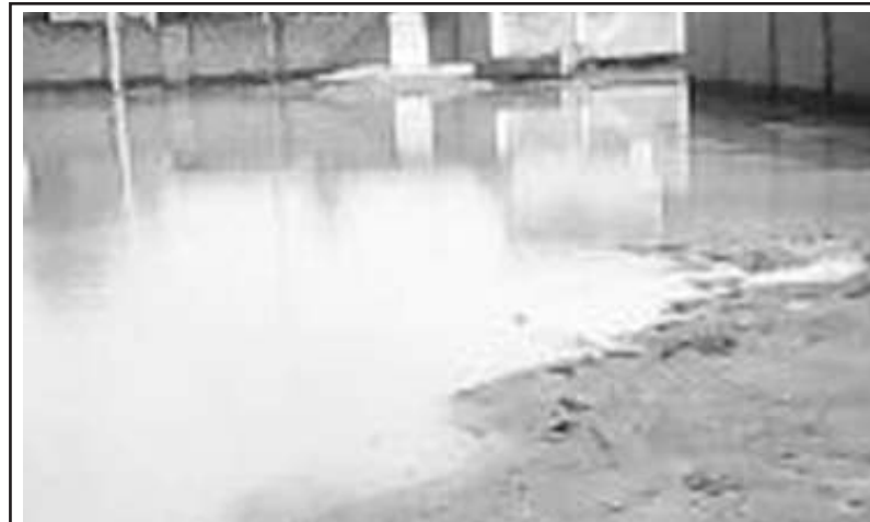
Vue partielle du bassin d'Adidoadin débordé par les eaux
