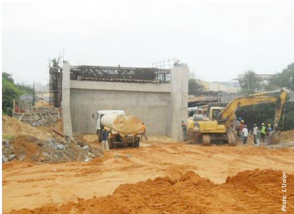
Le pont de l'embouchure d'Aného en construction
