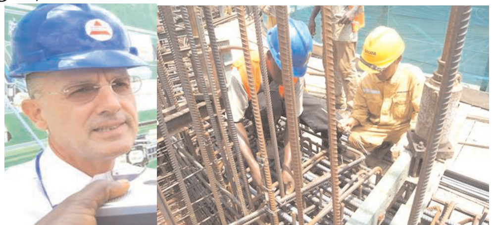
L'Ambassadeur Joseph Weiss en visite sur le chantier confié aux Chinois
