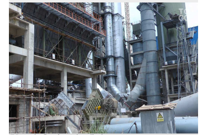
Vue de l'usine de clinker
