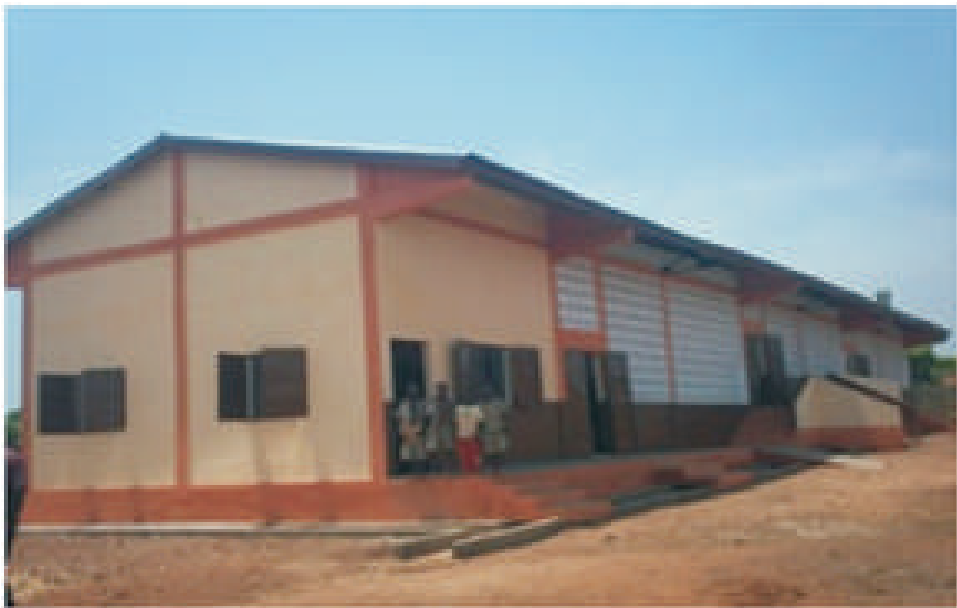
Un bâtiment scolaire construit dans le cadre du PERI-1
