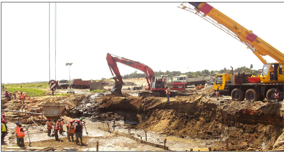
Travaux d'assainissement dans un quartier de Lomé.
