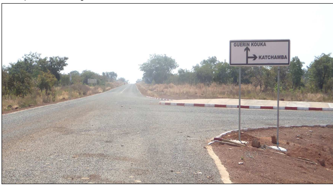
Vue partielle du tronçon Kouka - Katchamba
