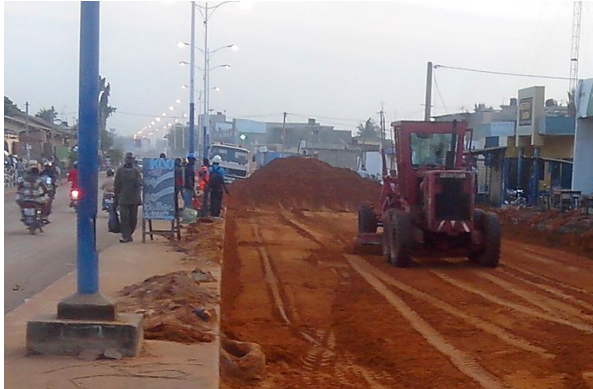
Travaux sur une route à Lomé
