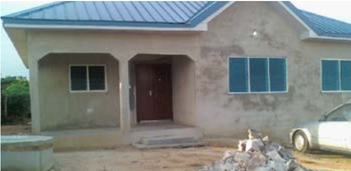
Une habitation en construction
