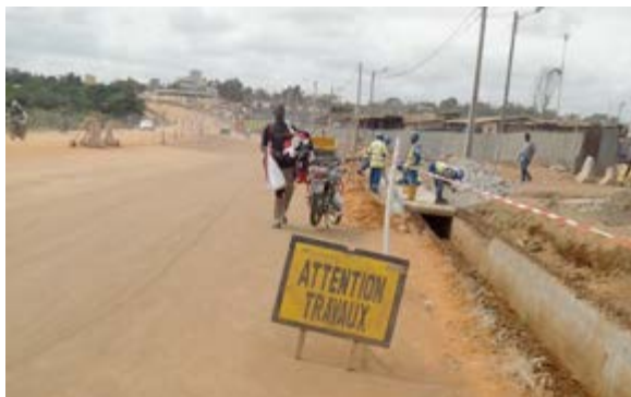
Une route en chantier à Lomé
