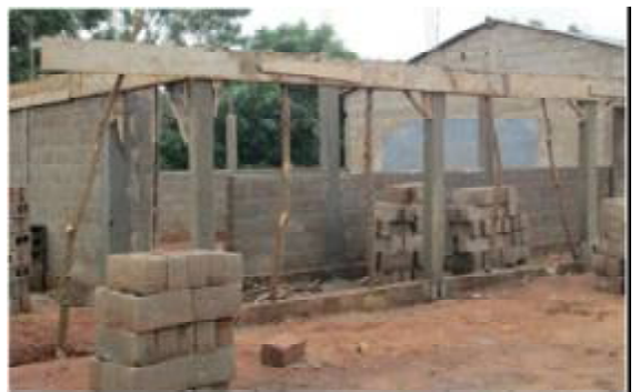
Un bâtiment scolaire en construction
