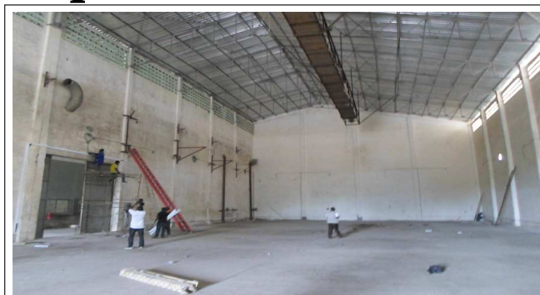
Le centre d'entreposage du matériel humanitaire en plein chantier
