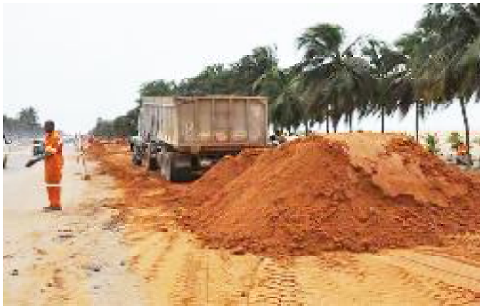
Travaux de construction de routes
