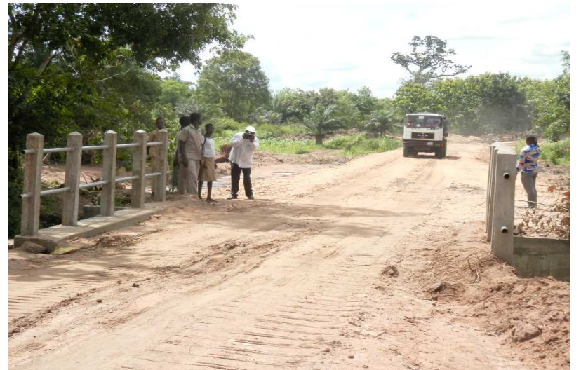
Un pont rénové à Adzrakpo grâce au PGICT
