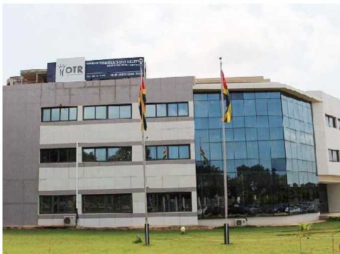
Vue partielle du bâtiment du siège de l'OTR à Lomé
