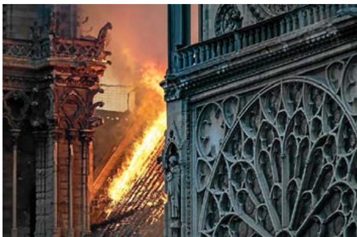
Vue partielle des feux emportant une partie de l'édifice
