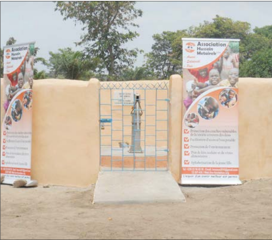
Vue du forage
