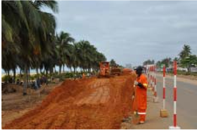
Un chantier de route à Lomé
