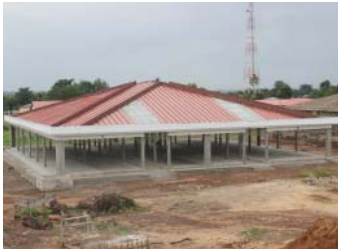
Hangar type préfabriqué marché d'Elavagnon
